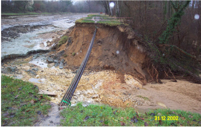
Figure 4: le canal latéral à la Loire. Décembre 2002
