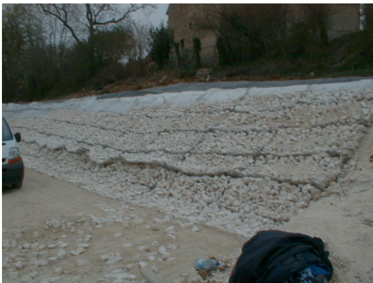
Figure 7 : Canal de Briare - digue de Montambert : utilisation expérimentale de Gabions
