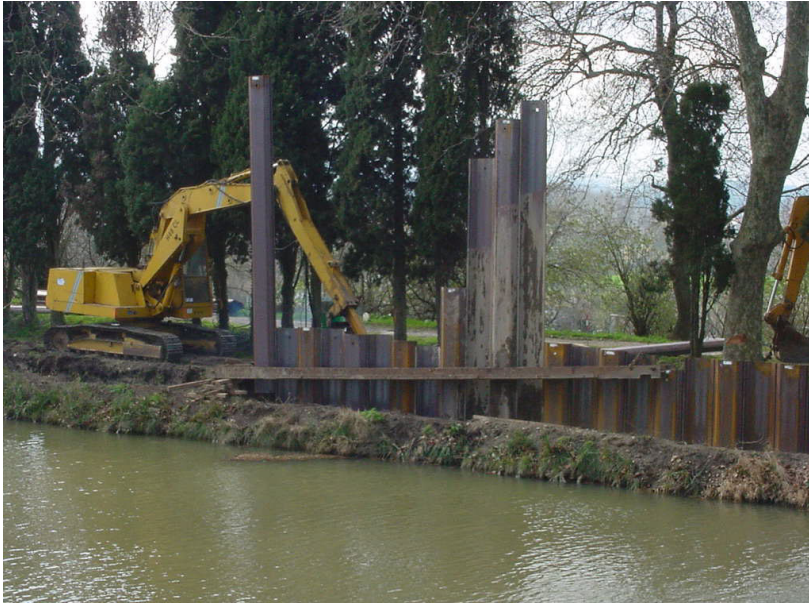
Figure 9: Canal du Midi – bief de Trèbes : utilisation d'un rideau de palplanches
