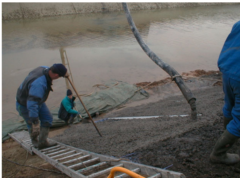
Figure 8 : Canal du Nord – réparation de la dalle Béton
