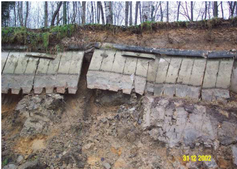
Figure 5: le canal latéral à la Loire. Décembre 2002
