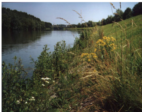
Pied de digue protégé par un matelas végétalisé
