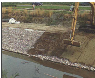
Mise en place de terre végétale dans la structure
