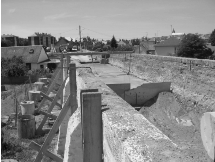
Figure 6 : Travaux de renforcement de la levée des Ponts Chartrains protégeant le quartier de Vienne (commune de Blois)
