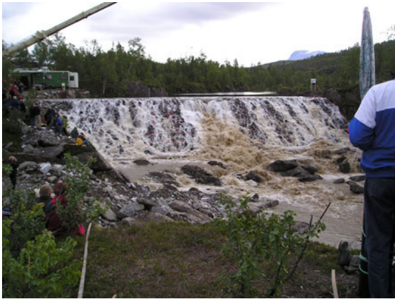
Photo 2 : Erosion du parement aval durant la phase d'initiation de la brèche (cf. réf [1])
