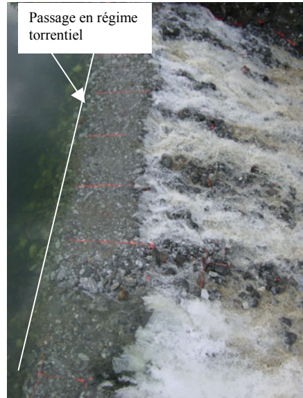
Photo 1 : Zone de passage en régime torrentiel dans un écoulement de surverse (cf. réf [1]).
