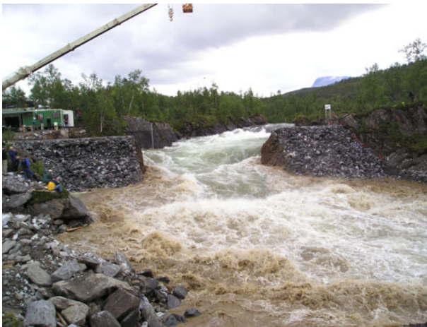
Photo 3 : Brèche dans ses dimensions finales (cf. réf [1])
